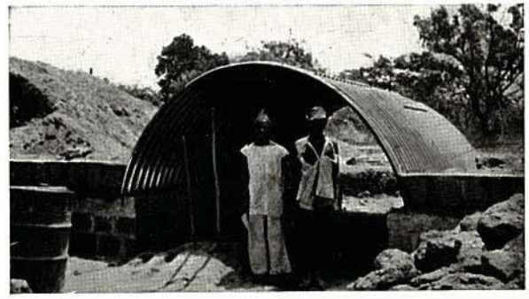
Die Montage eines Multiplech-Bogens ist einfach und erfordert weder gelernte Arbeiter noch teure Hebevorrichtungen. (Französisch-Guinea)
