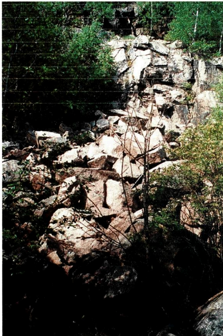
Bilde 2.5: Bilde viser steinur ved foten av fjellskjæringa .
