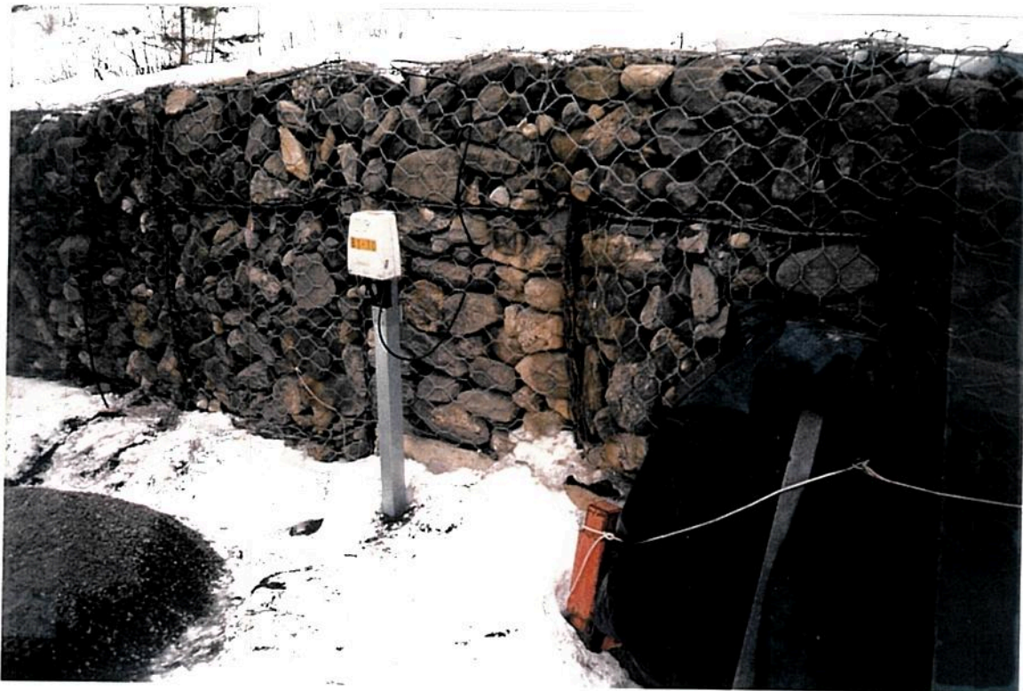
Gabionmur på betongfundament
