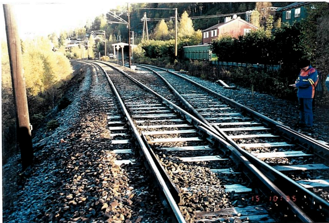
Sporveksel sett mot Tynset
