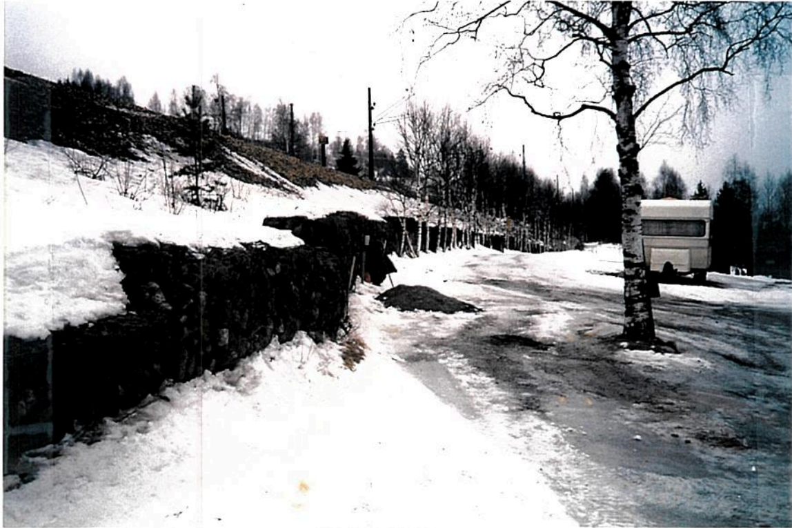
Utsnitt av gabionmur
