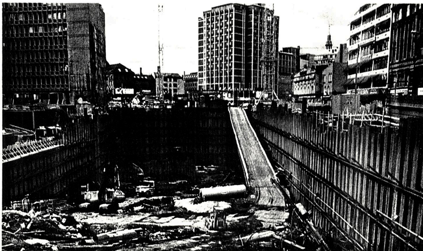
Hovedkontoret Selmer Sande, Oslo City. Her leverte vi ca. 1300 tonn stålpunt profil Larssen 430 i lengder opp til 23.5 m.
