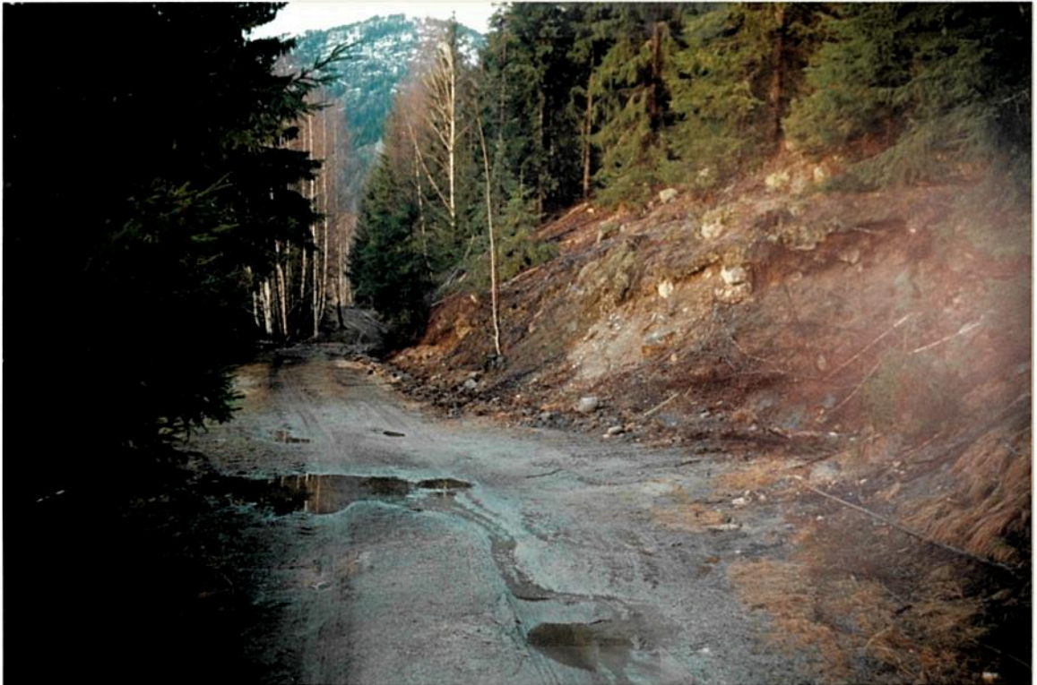
Skjæring i skråningsfot
