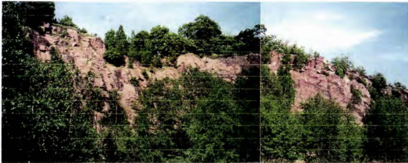
Bilde 2.1: Oversiktsbilde av fjellskråningens midtparti (til venstre) og østre side (til høyre).
