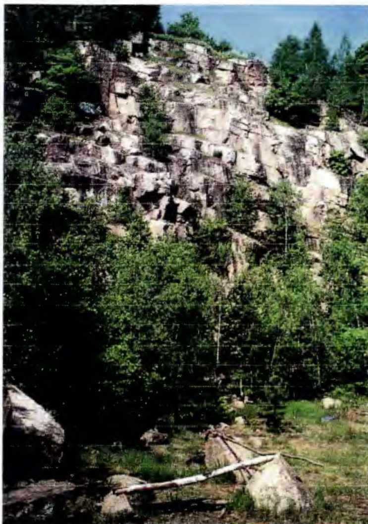
Bilde 2.2: Midtpartiet sett fra syd-vest. Bildet viser fjellets markerte benkningsplan som stuper ca 20° ut av skjæringa.
