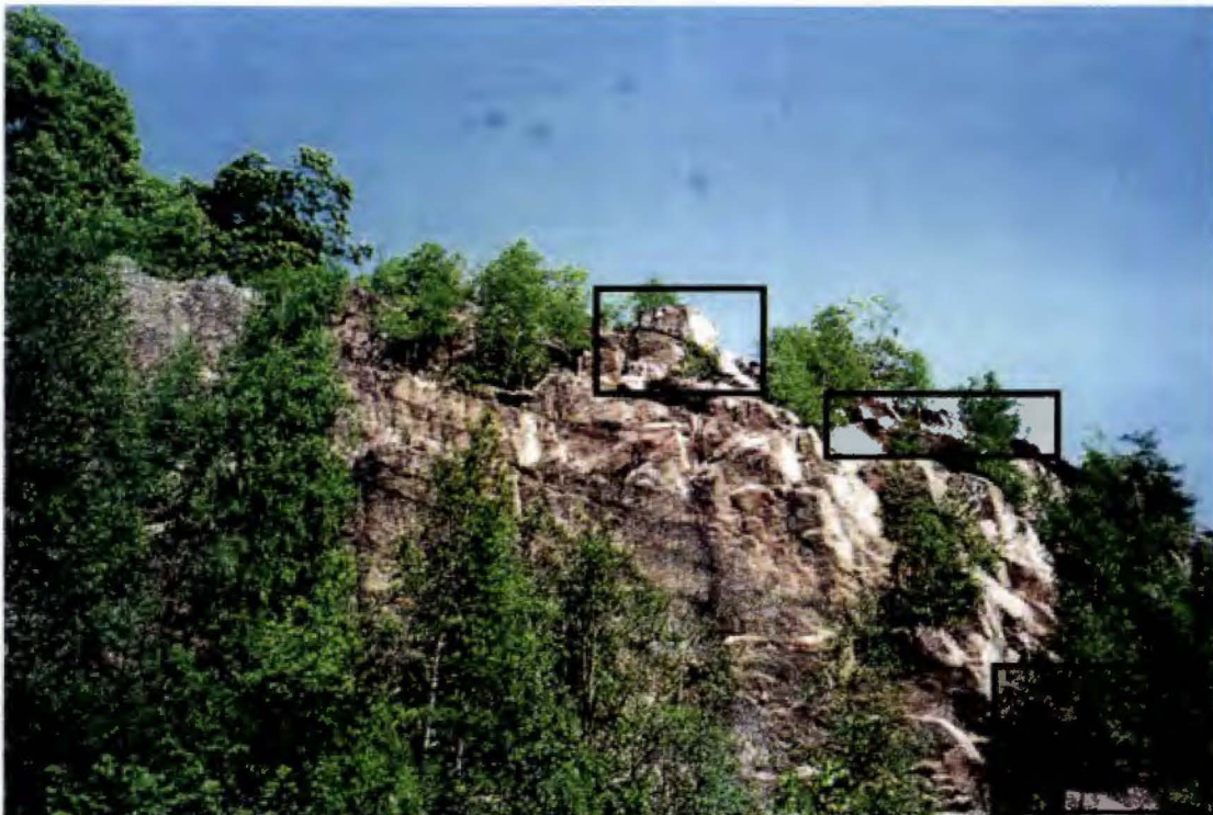
Bilde 2.4: Østre side. Bilde viser den vertikale, slette fjellsida til venstre (delvis dekket av trær i forgrunnen) og løse steinblokk på toppen. Blokk som må sikres/tas med er markert.
