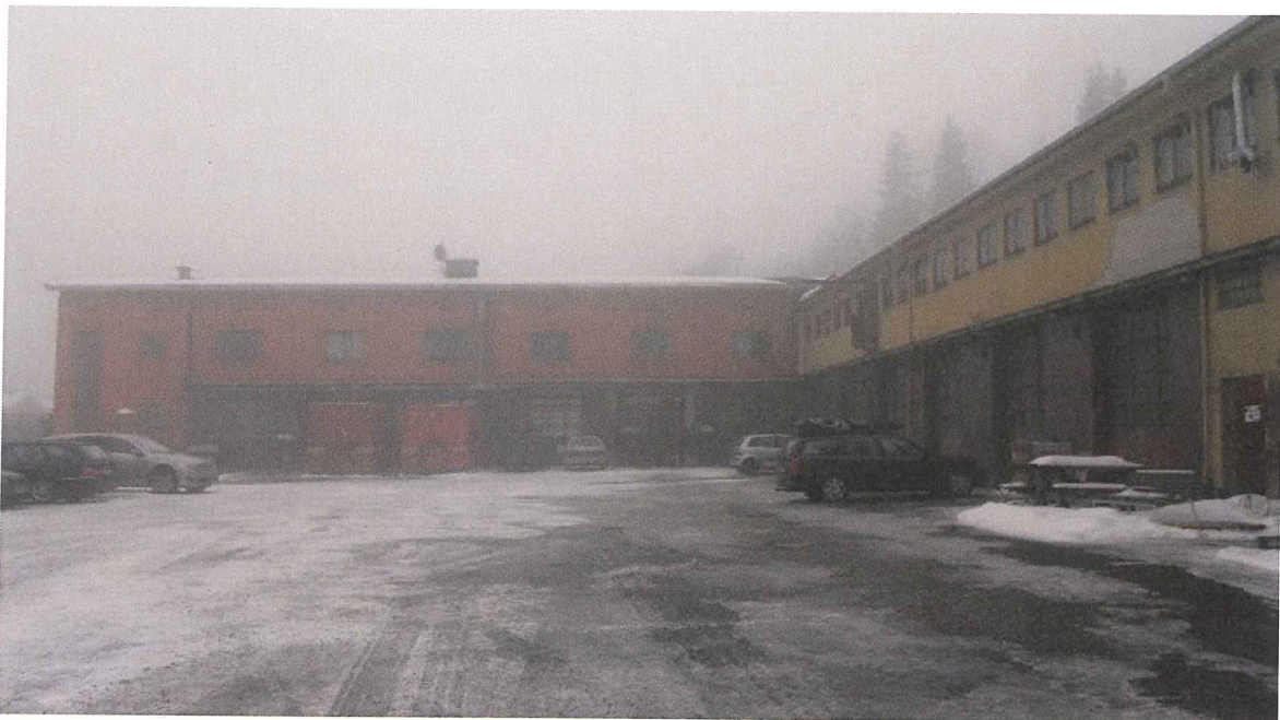
Bildet av eksisterende brannstasjon, tatt mot sørvest
