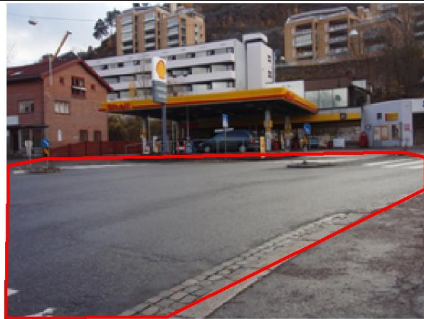
Foto 5: Krysset Konowsgate – Valhallveien fotografert mot syd. Området hvor den prosjekterte traséen i Konowsgate – Valhallveien kan ligge er markert med rødt.
