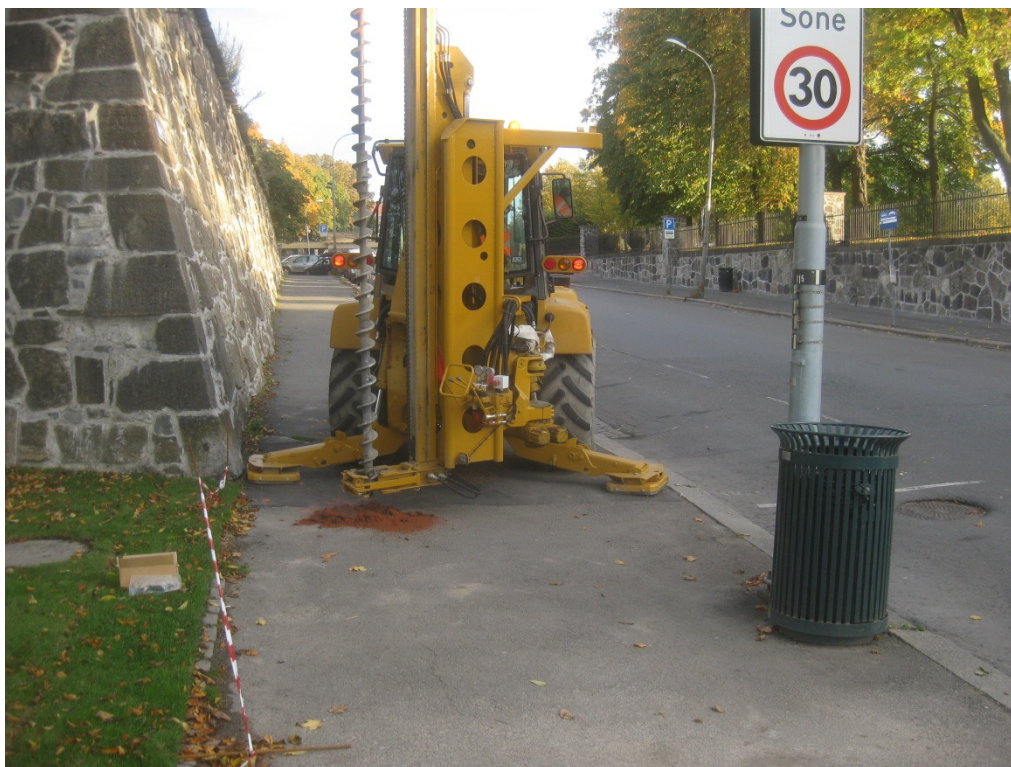
Bilde 3: Område for plassering av boring B4 ved Kongens gate.
