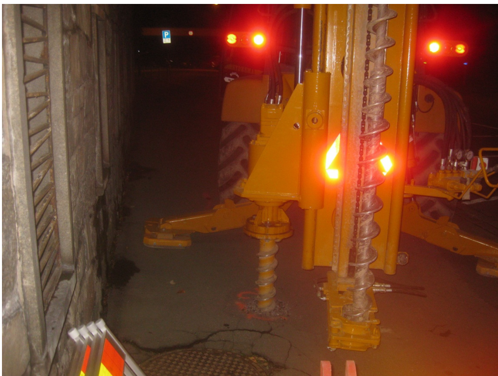
Bilde 2: Område for plassering av boring B2 ved Kongens gate.
