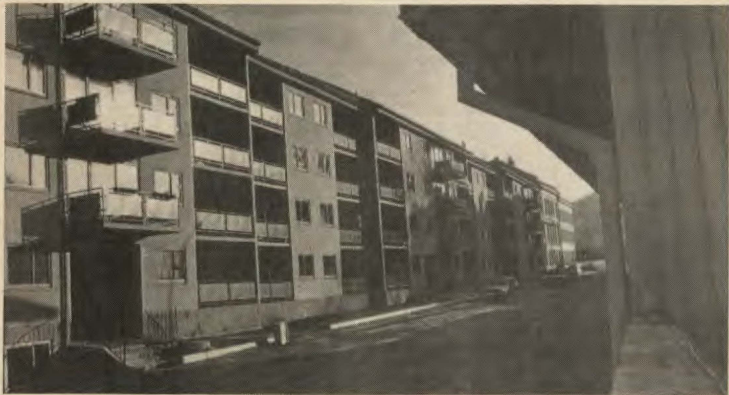
Smdlensgaten 4-14 på Vålerengen står allerede ferdig, etter 17 måneders byggetid. 55 leiligheter er resultatet, med innskudd fra 175 000 ned til 96 000.
