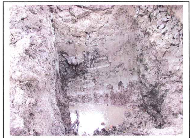
Fyllmasser og noe vann i punkt 11
