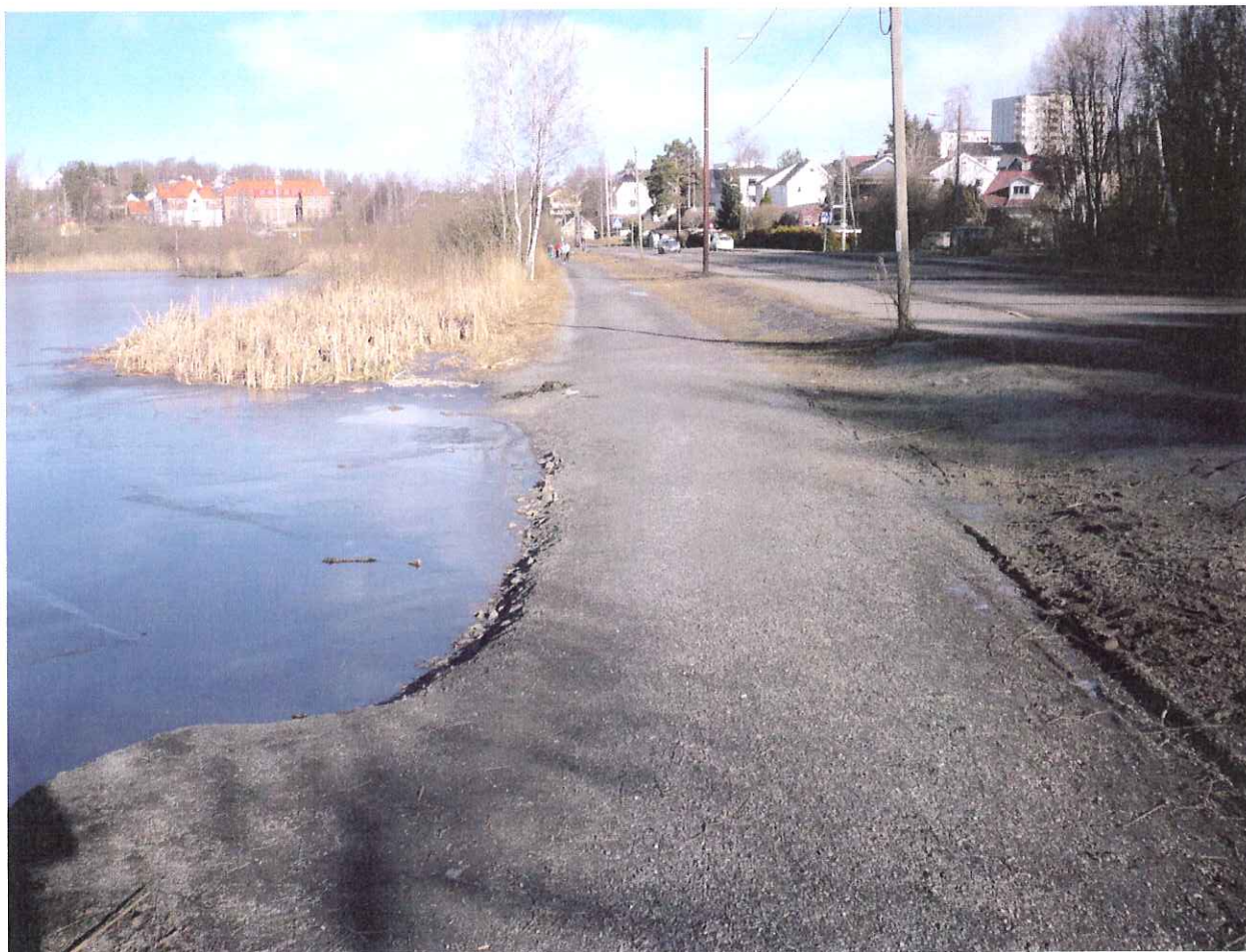
Bilde fra ca. profil 2200 sett mot nord
