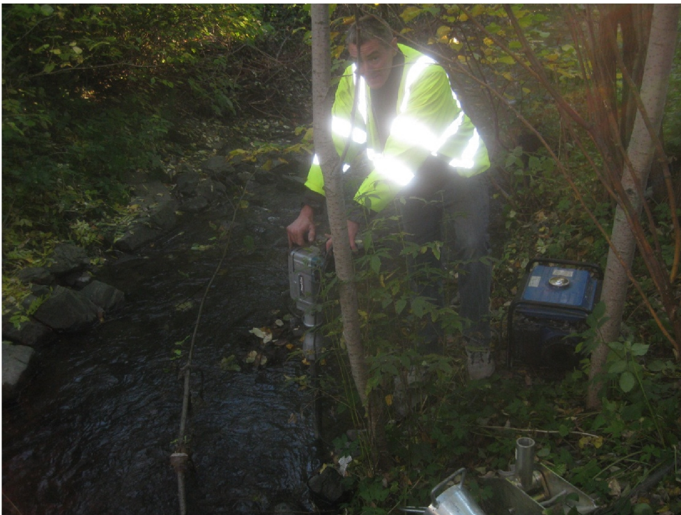
Bilde 2: Område for plassering av boring B3.
