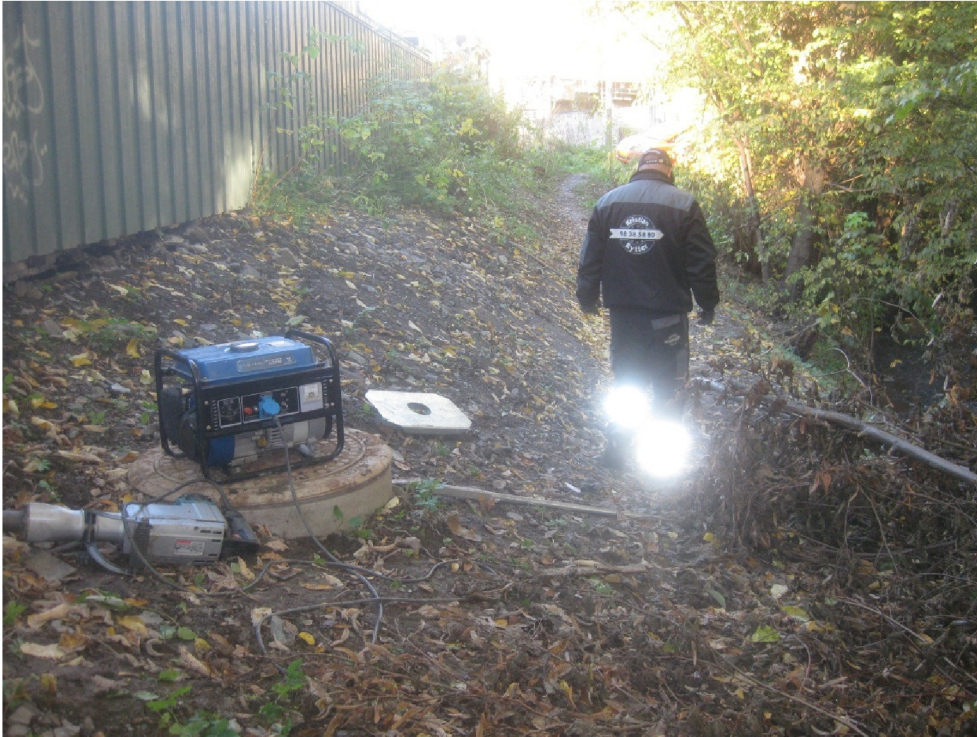
Bilde 1: Område for plassering av boring B2.
