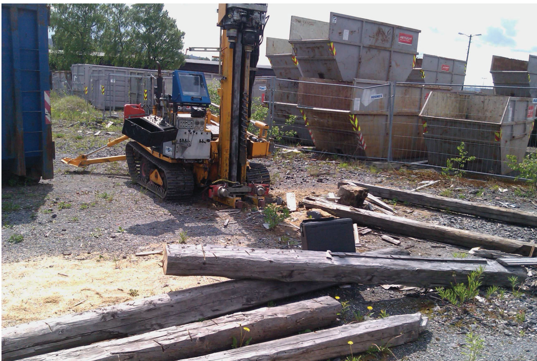
Figur 5: Oversiktsbilde mot sør. Riggeren står ved prøvepunkt M23 på asfaltområdet.
