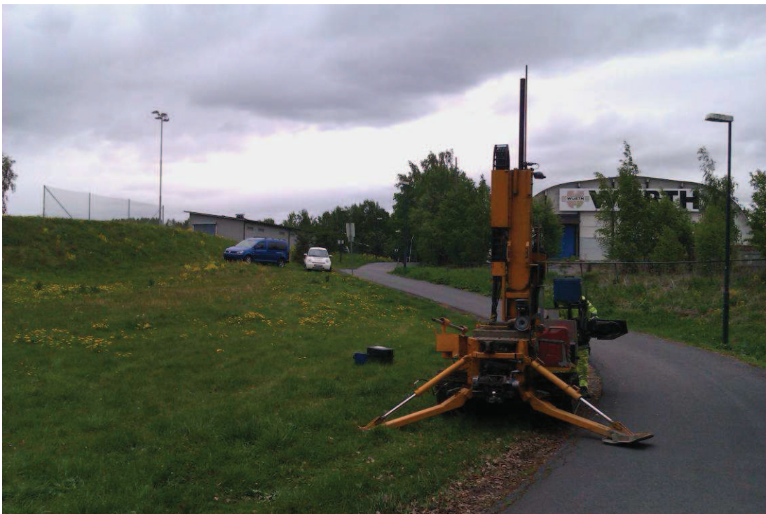
Figur 4: Oversiktsbilde mot nordøst. Riggeren står ved prøvepunkt M5 på gressområdet.
