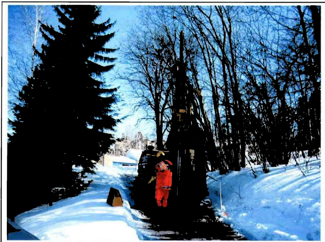
Bilde tatt mot øst i forbindelse med boring i punkt 7
