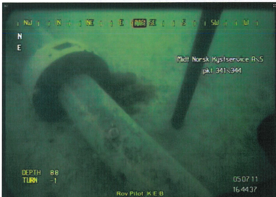
Figur 5-5 Snapshot fra ROV ved boring 342. Casing 30 cm fra vannledning til Biomar.
