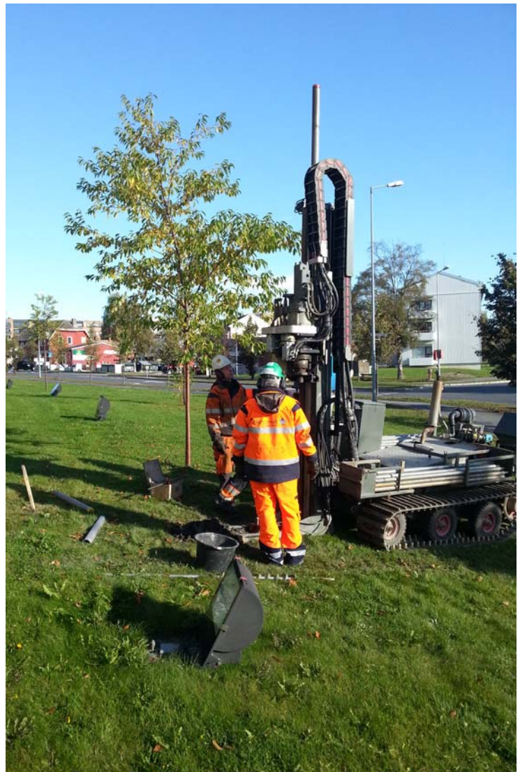
Fig.1: Prøvetaking ved borpunkt 4
