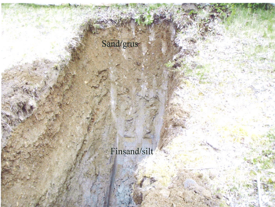
Bilde nr. 4: Løsmassene i PG.2; utsikt mot øst
