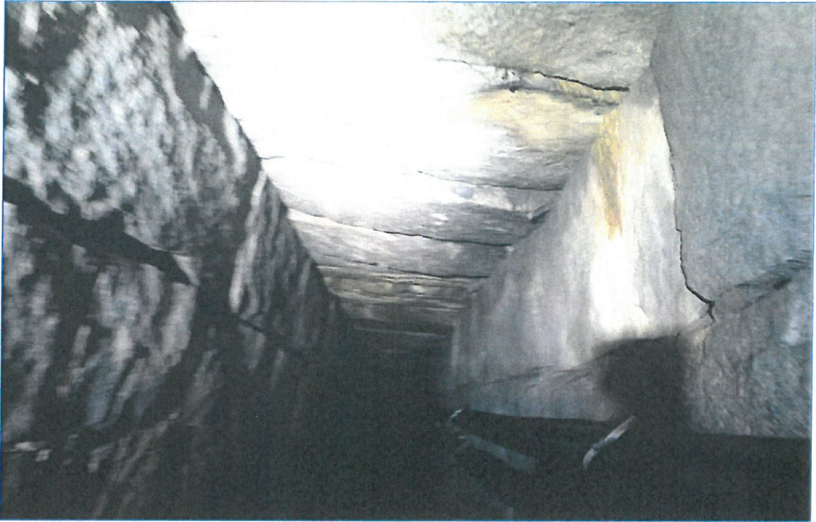
Bilde 06:00. Viser granitthellene i takkonstruksjonen.
