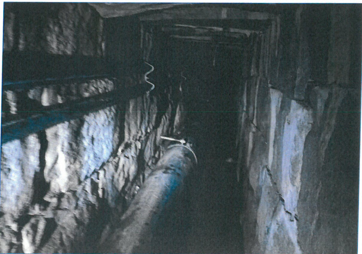
Bilde 03:41. Viser spillvannsrør og trekkerør til fiberkabler.
