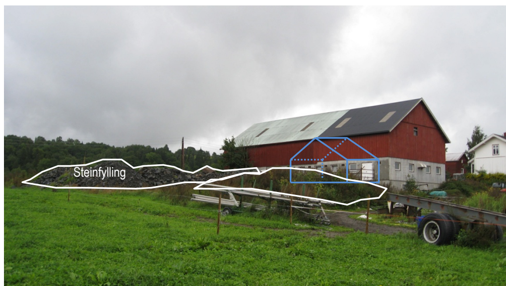
Figur 2.1: Planlagt tilbygg på fjøs, 15 x 15 m. Steinfylling og matjordranke som i dag er lagret der tilbygget er planlagt, er markert med hvite omriss.
