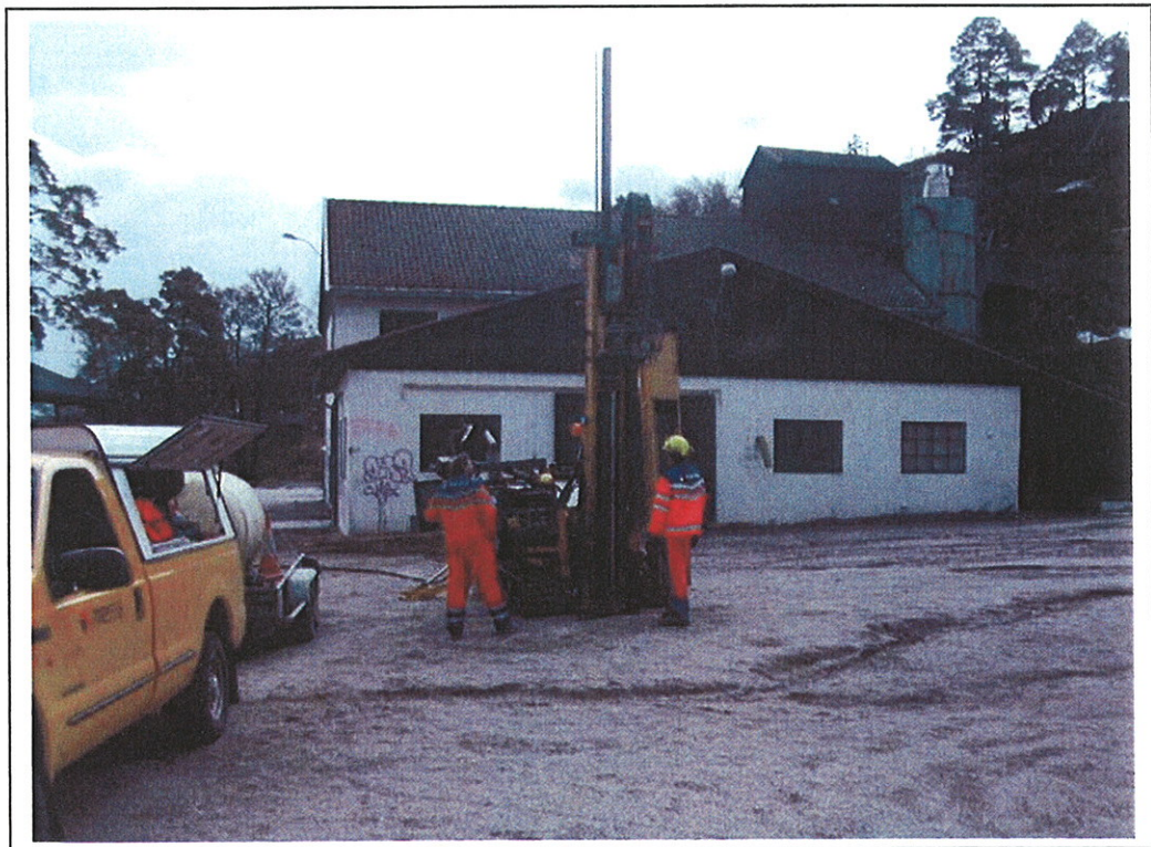
Bilde tatt mot sør under boring av pkt. 2, 24.04.2006
