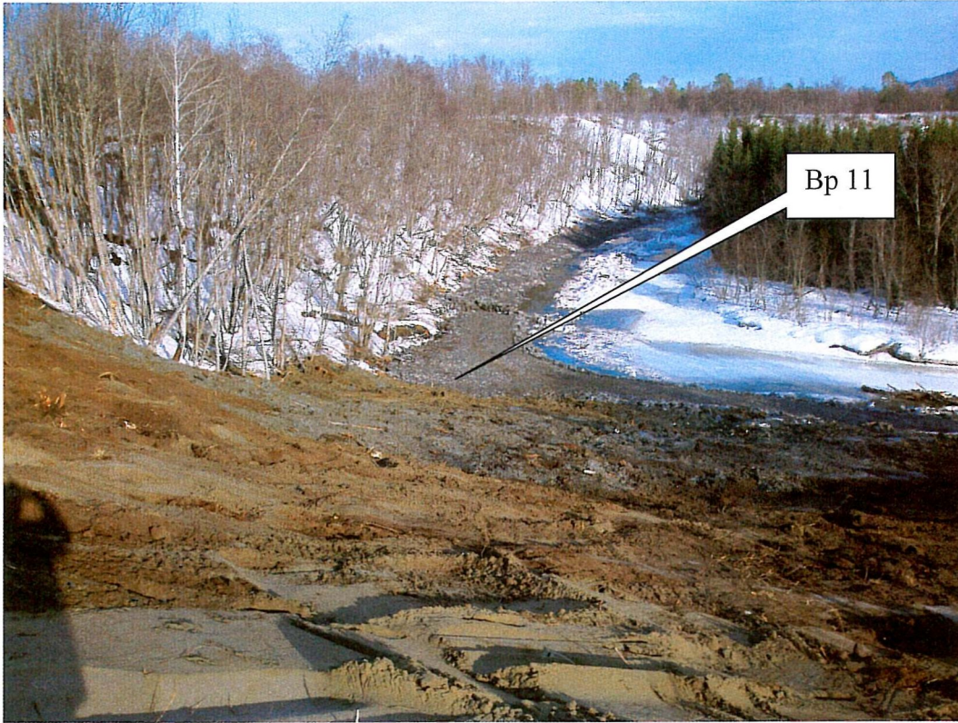
Tatt ovenfor rasgrop etter nedslaking av raskant – bakevje ved borpunkt 11 fylt igjen som del av forbygning
