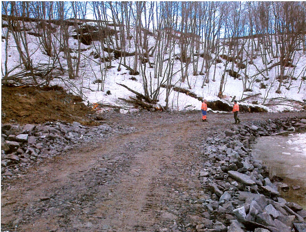
Ved rasgrop – retning oppstrøms
