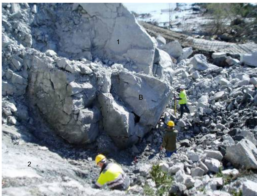
Foto 2. Nedre del av bergmasse som ser ut til å ha glidd ca. 1m langs sleppe 2. Massen er avløst av sleppe 1 i sør. Blokk B i front.
