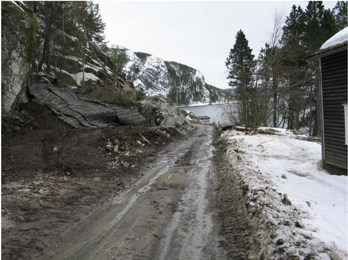
Figur 6 Sprengningsområdet før skredet sett sørover, med Kattmarkvegen 55 til høyre i bildet. Bildet er tatt den 12. mars kl. 15.09 etter at salve 18 er skutt og viser mattene som dekket denne salven. Foto: Statens vegvesen
