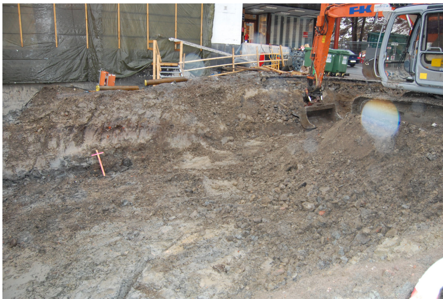
Figur 3.2. Bildet viser et typisk jordprofil med asfalt, fyllmasser (grus) i toppen og naturlig avsatt leire under (Foto fra Kongens gate).
