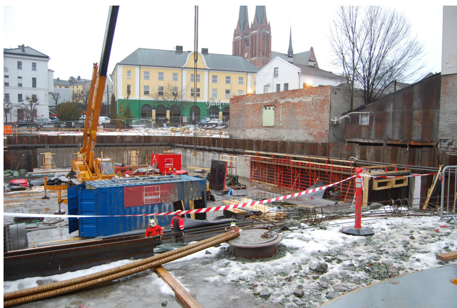
Figur 4.1 Viser sikring av byggegrop.
