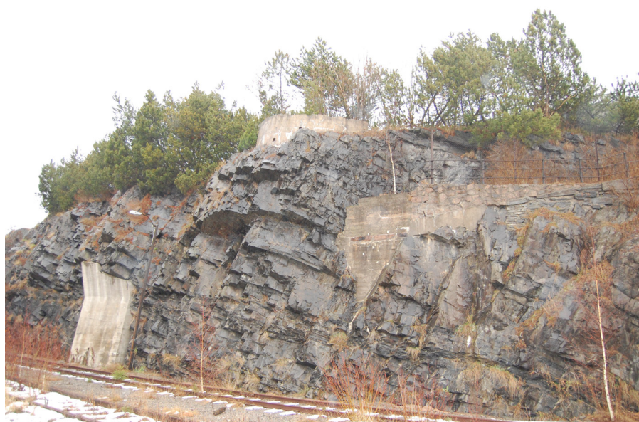
Figur 4.2 Viser bergskrent mot øst som er sikret med betongkonstruksjon.
