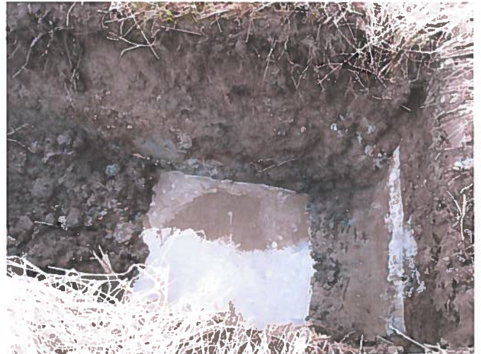
Bilde 5. Masser i oppgravd gravehull 2.
