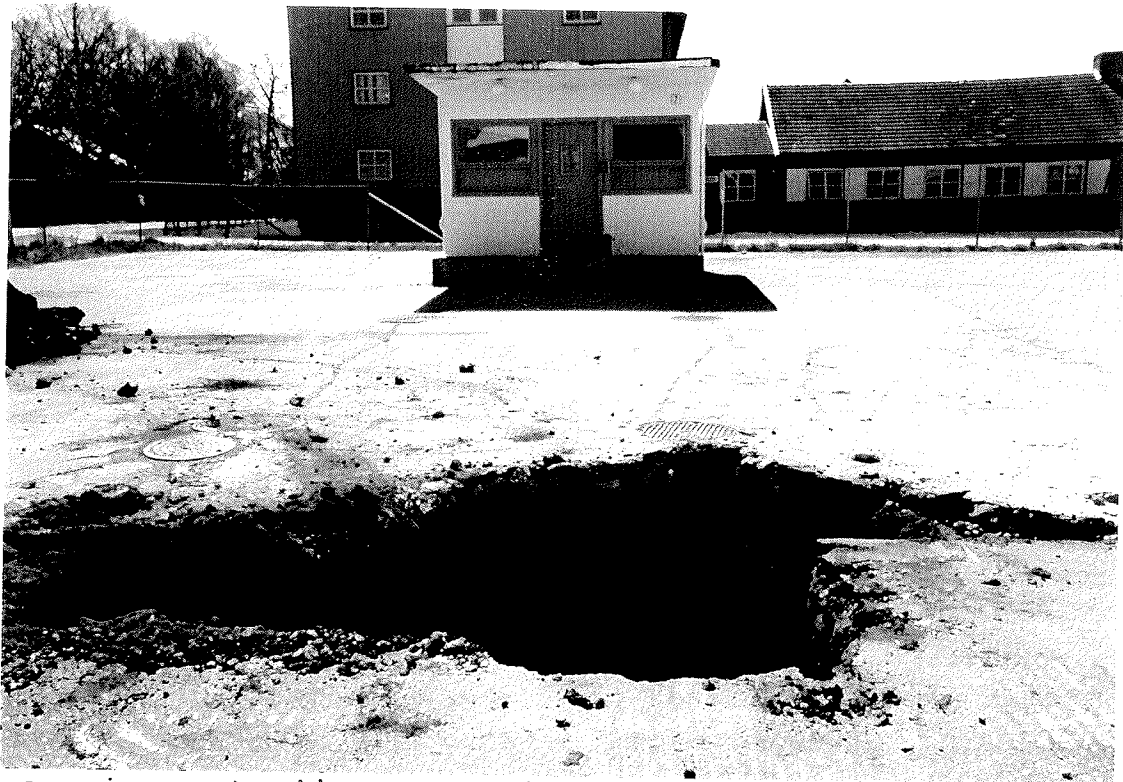
Bensin- og dieseltankene ligger under betongplata, mot pumpehuset. Begge mannlukkene sees.
