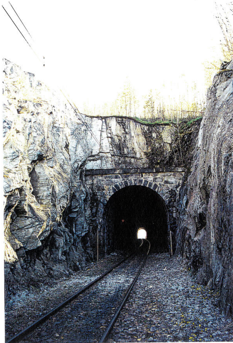
Bilde 5.1.2. Nordre påhugg til Raumabanetunnelen (km. 343.422).
