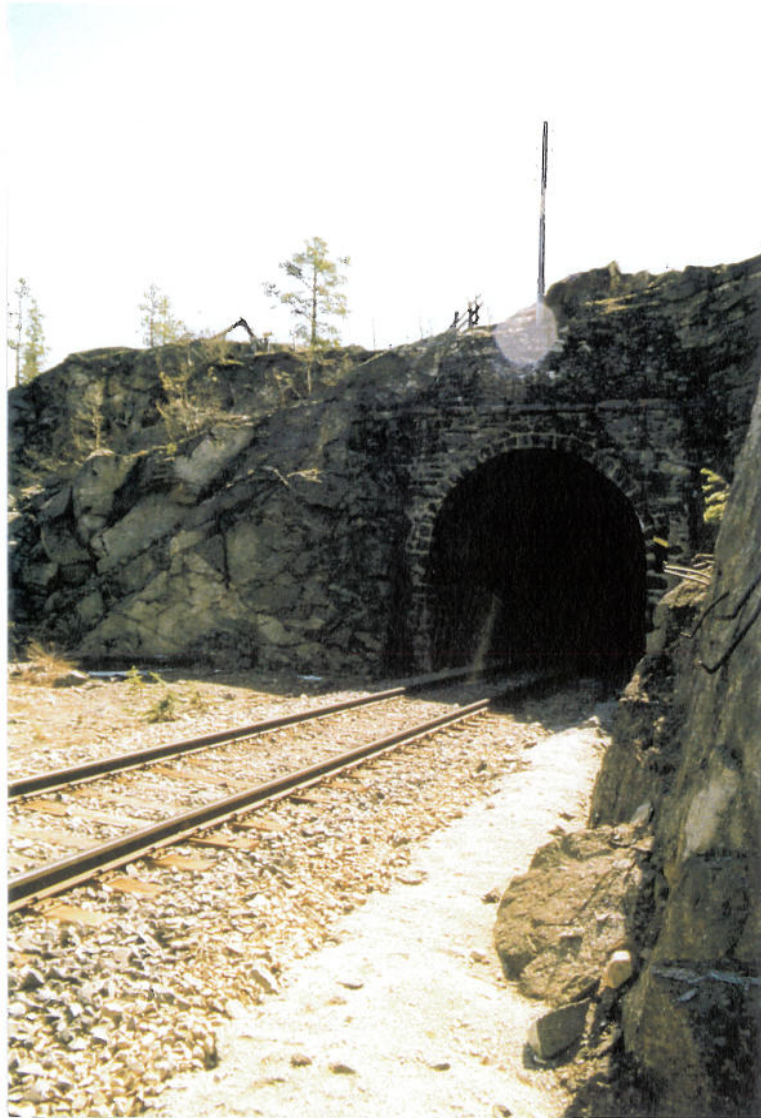
Bilde 5.3.2. Nordre påhugg til Bjorli tunnel (km. 401.253).
