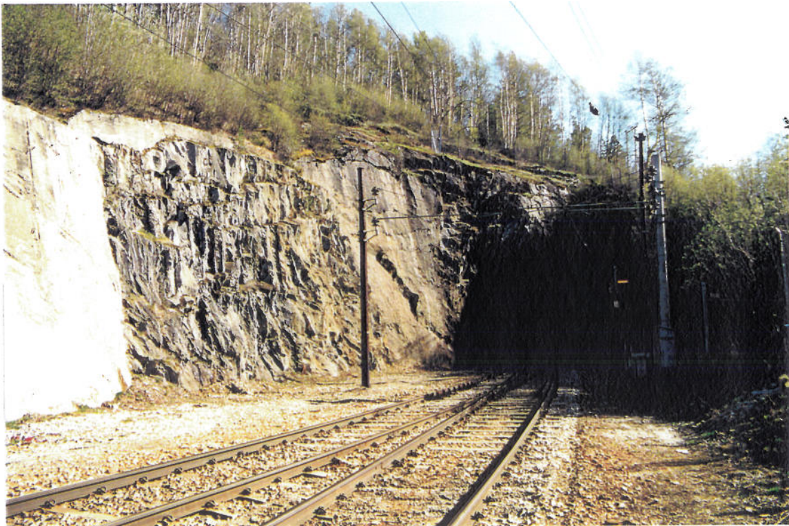
Bilde 4.7.2. Nordre påhugg til Dombås syd tunnel (km. 342.587).
