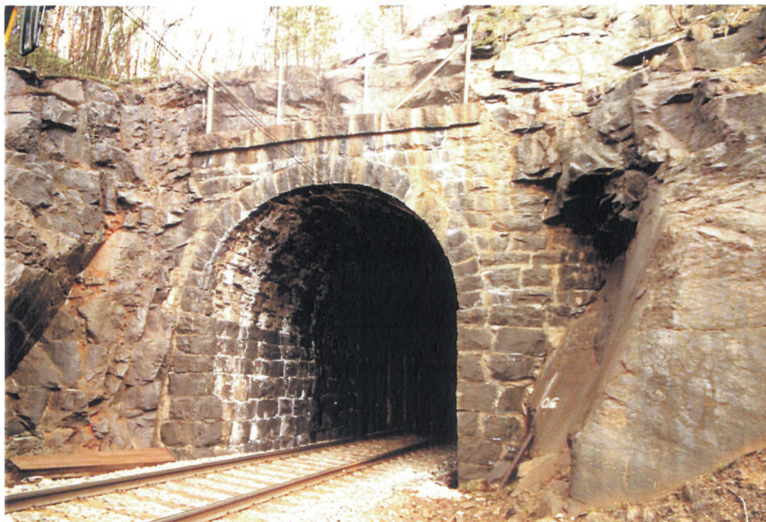
Bilde 4.9.4. Nordre påhugg til Grønbogen vendetunnel (km. 350.850).
