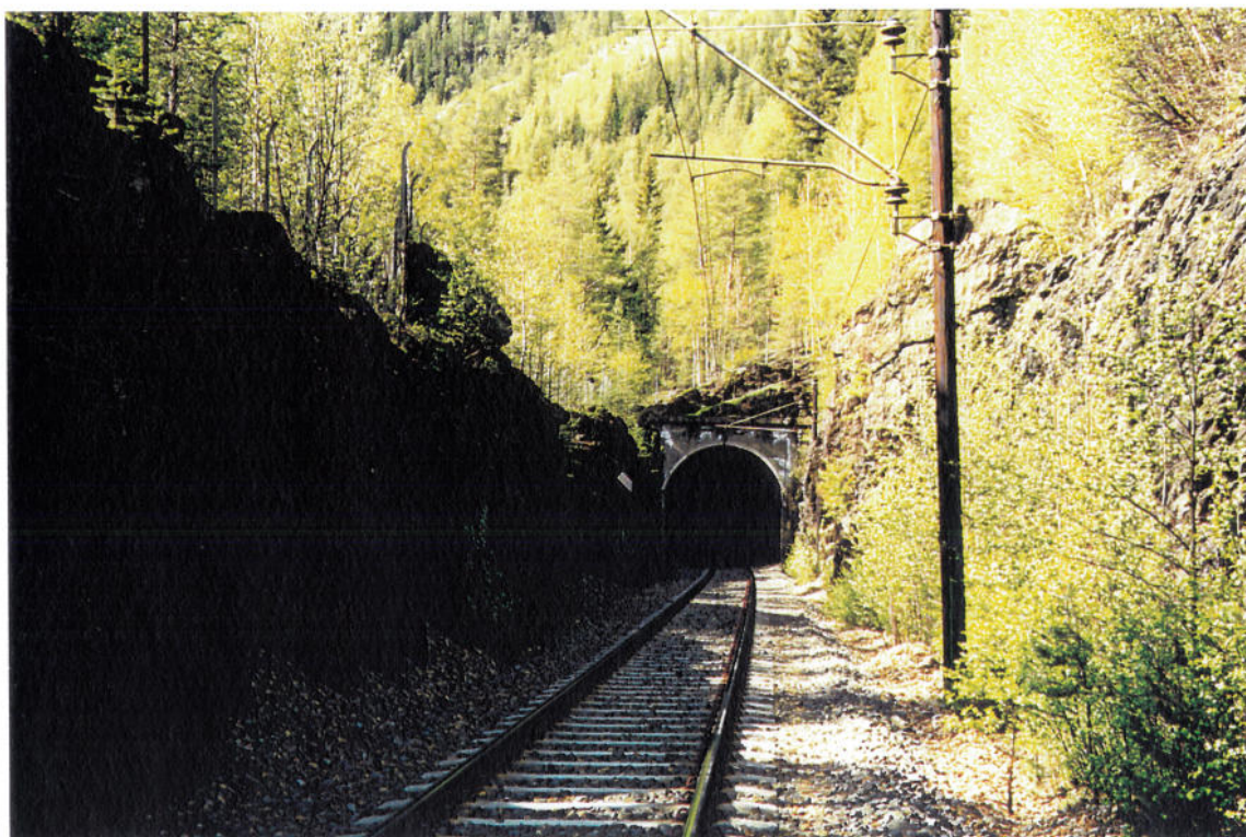
Bilde 4.4.2. Nordre påhugg til Midtre Rosti tunnel (km. 312.752).
