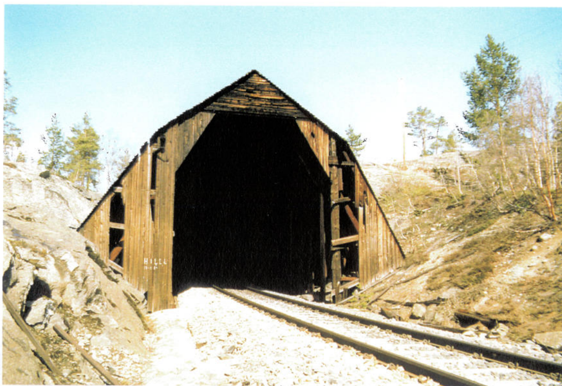
Bilde 5.3.1. Søndre påhugg til Bjorli tunnel (km. 401.060)
