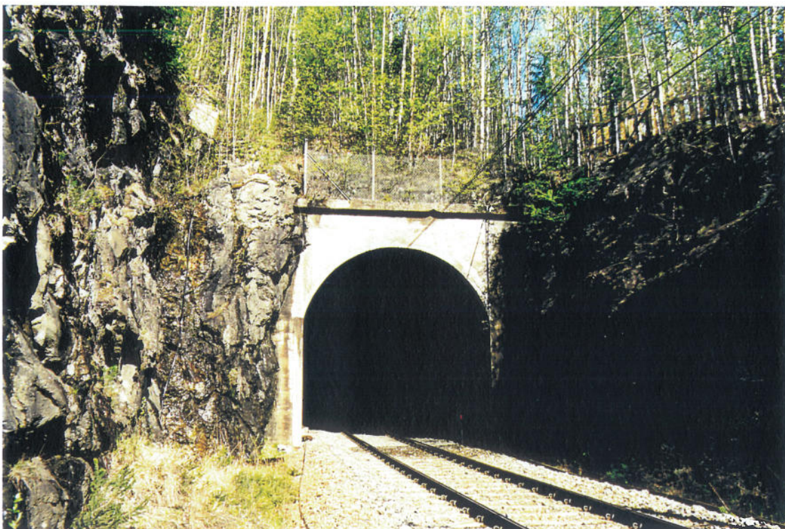
Bilde 4.3.1. Søndre påhugg til Søndre Rosti tunnel (km. 312.231)
