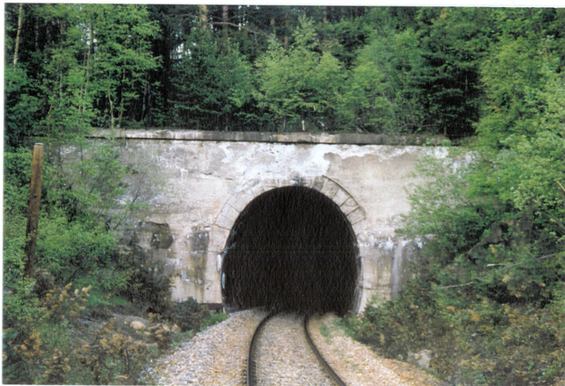
Bilde 5.4.2. Nordre påhugg til Stavem vendetunnel(km. 415.790).
