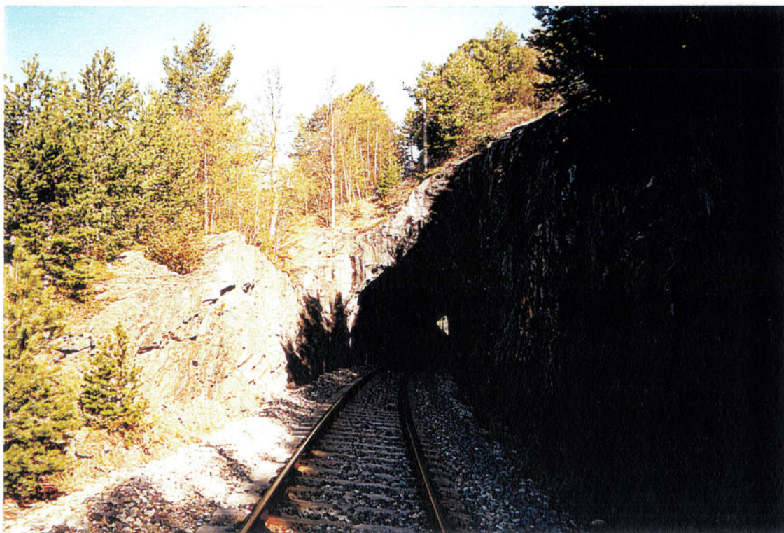
Bilde 5.2.1. Søndre påhugg til Bottemstunnelen (km. 350.795)
