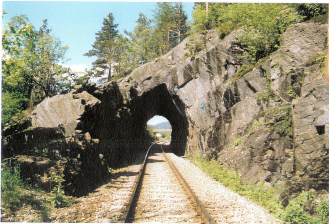
Bilde 5.6.2. Nordre påhugg til Åk tunnel(km. 452.409).
