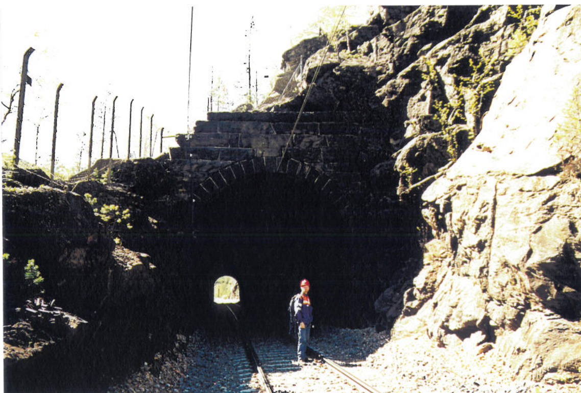
Bilde 4.5.2. Nordre påhugg til Nordre Rosti tunnel (km. 315.065).
