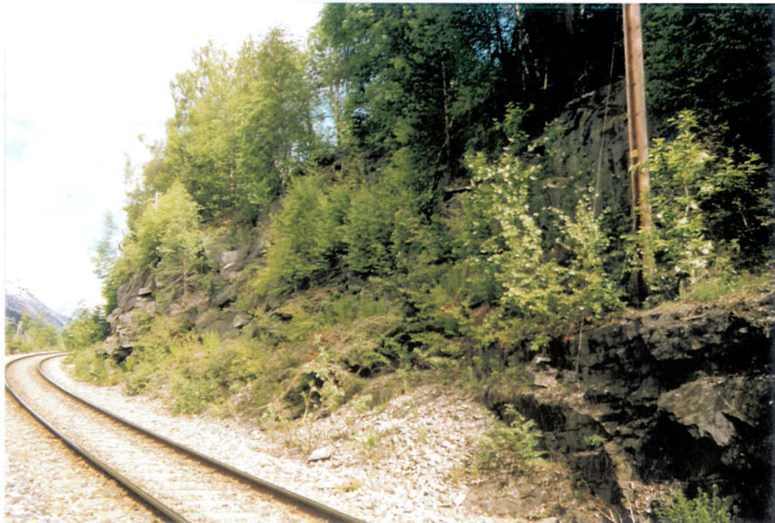
Bilde 5.5.1.1. Skjæring til Kylling tunnel.
