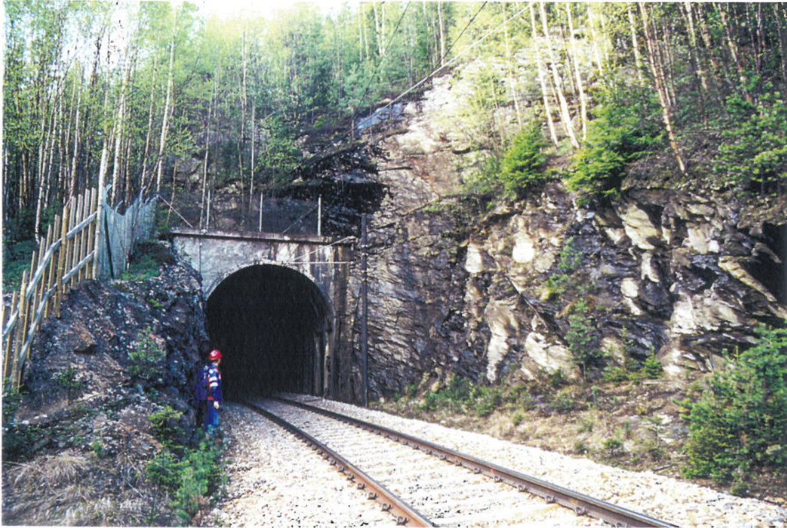
Bilde 4.3.3. Nordre påhugg til Søndre Rosti tunnel (km. 312.367)
