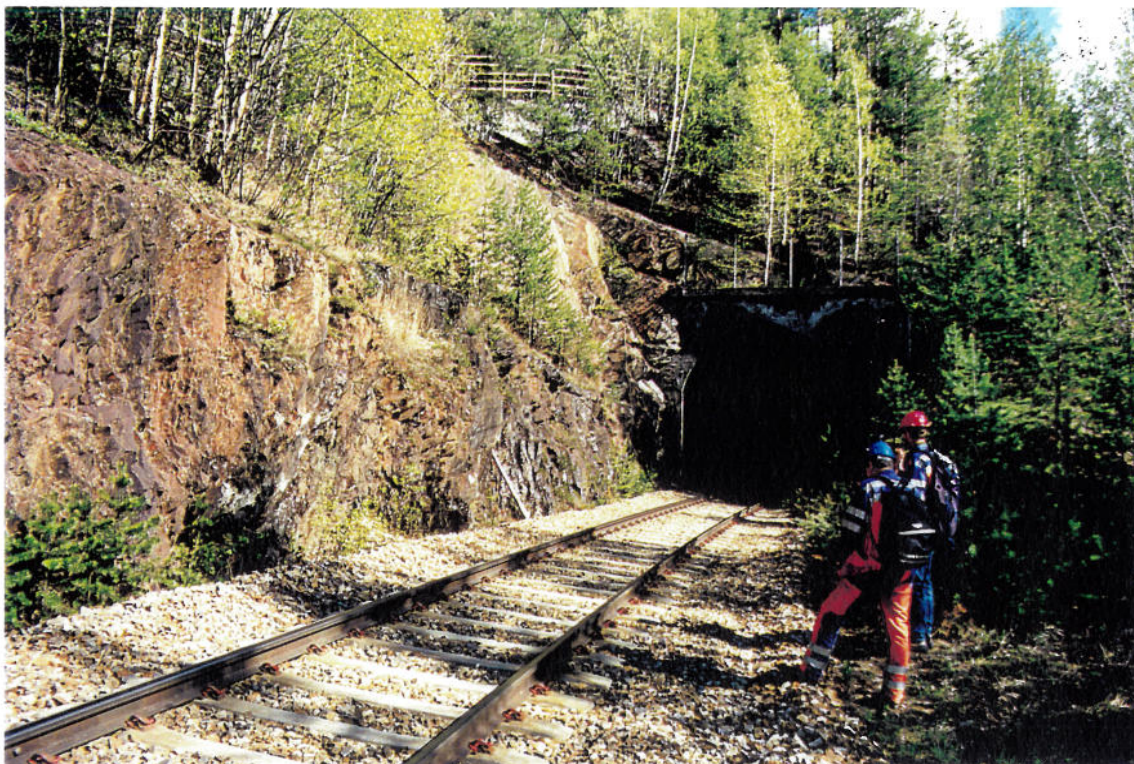
Bilde 4.4.1. Søndre påhugg til Midtre Rosti tunnel (km. 312.593)
