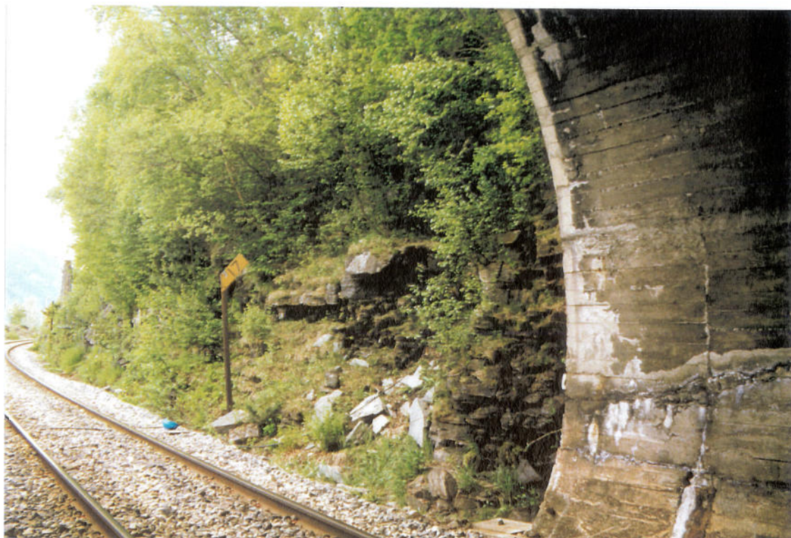
Bilde 5.5.1.2. Skjæring til Kylling tunnel.
