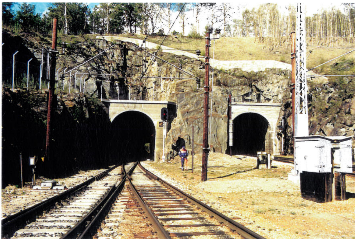
Bilde 5.1.1. Søndre påhugg til Raumabanetunnelen (km. 343.263)
