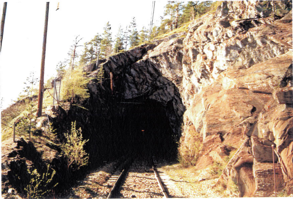
Bilde 4.7.1. Søndre påhugg til Dombås syd tunnel (km. 342.385)
