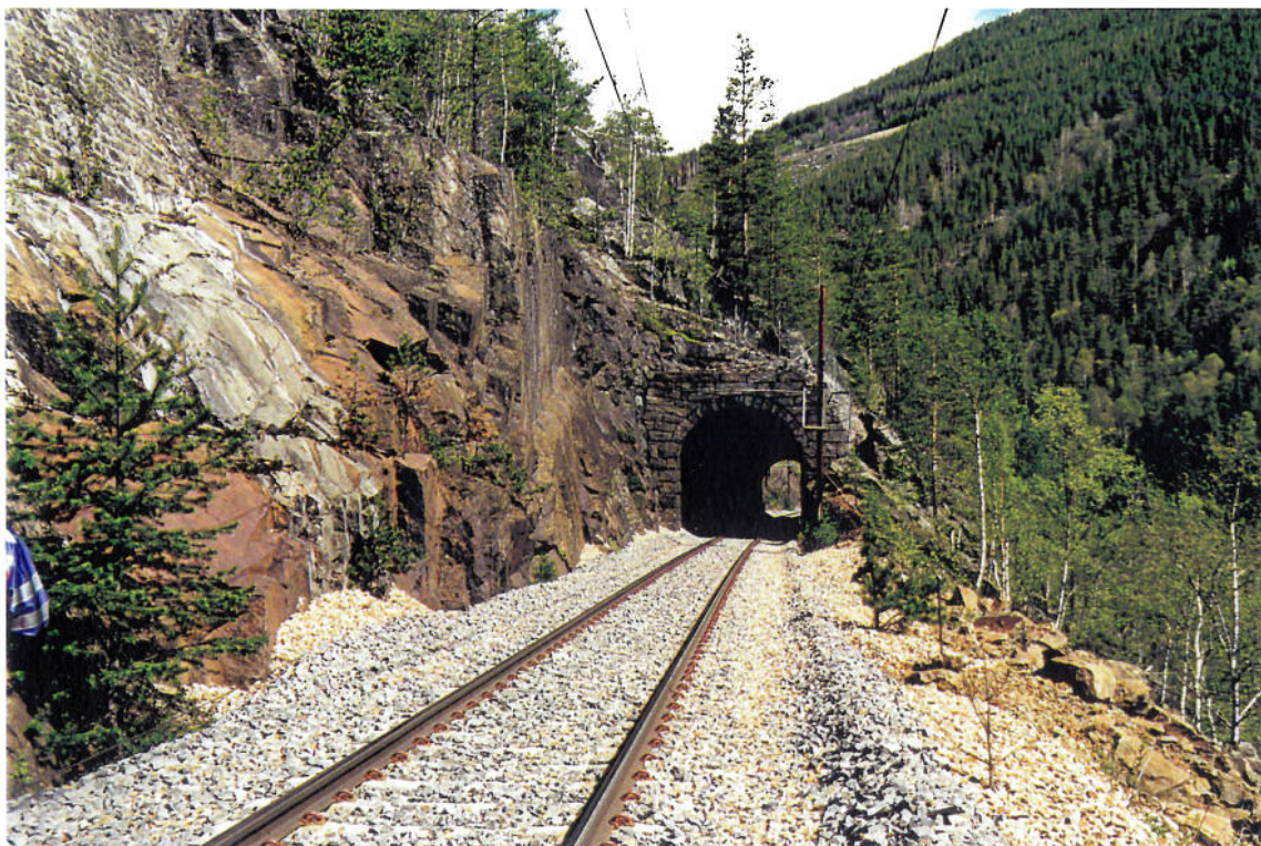
Bilde 4.5.1. Søndre påhugg til Nordre Rosti tunnel (km. 313.980)
