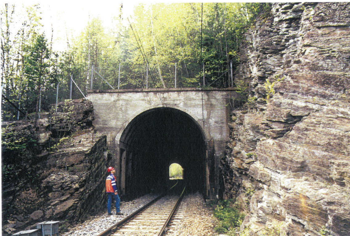
Bilde 4.2.4. Nordre påhugg til Nordre Rankleiv tunnel (km. 240.870).
