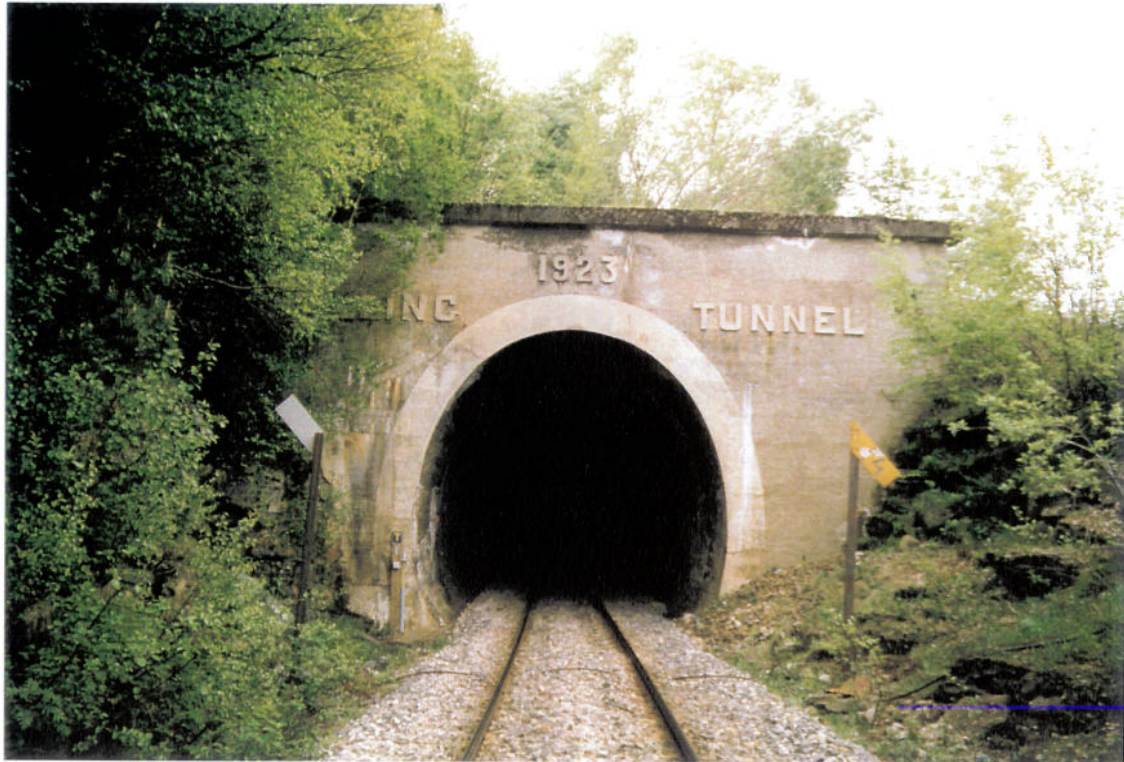
Bilde 5.5.1. Søndre påhugg til Kylling tunnel (km. 418.600)
