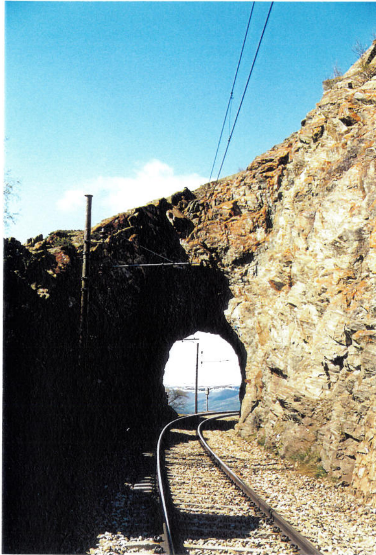
Bilde 4.6.1. Søndre påhugg til Schjelle tunnel (km. 341.011)
