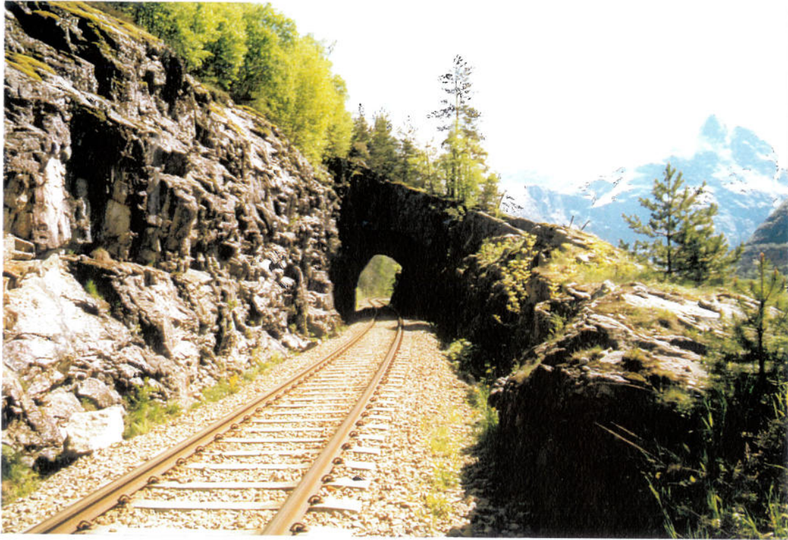
Bilde 5.6.1. Søndre påhugg til Åk tunnel (km. 452.375)
