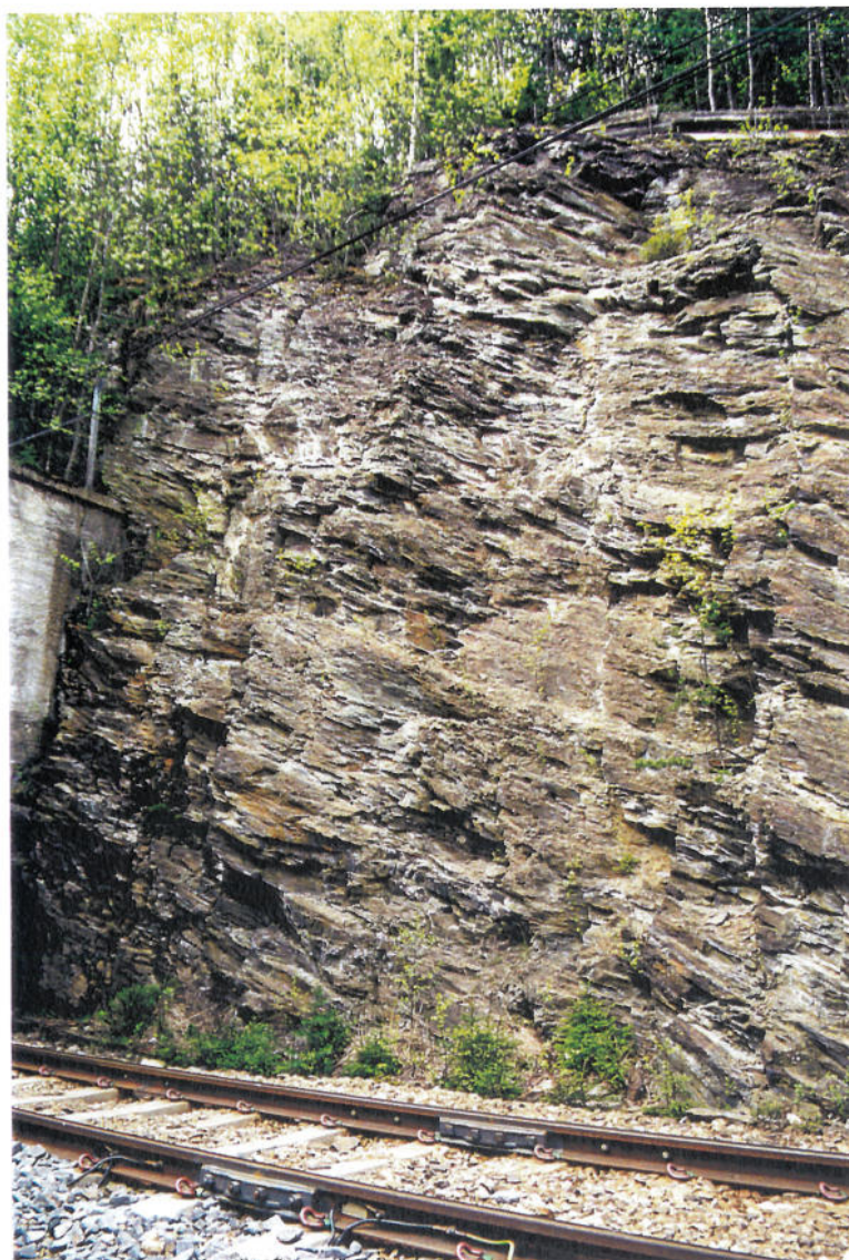
Bilde 4.2.3. Nordre påhugg til Nordre Rankleiv tunnel (km. 240.870).
