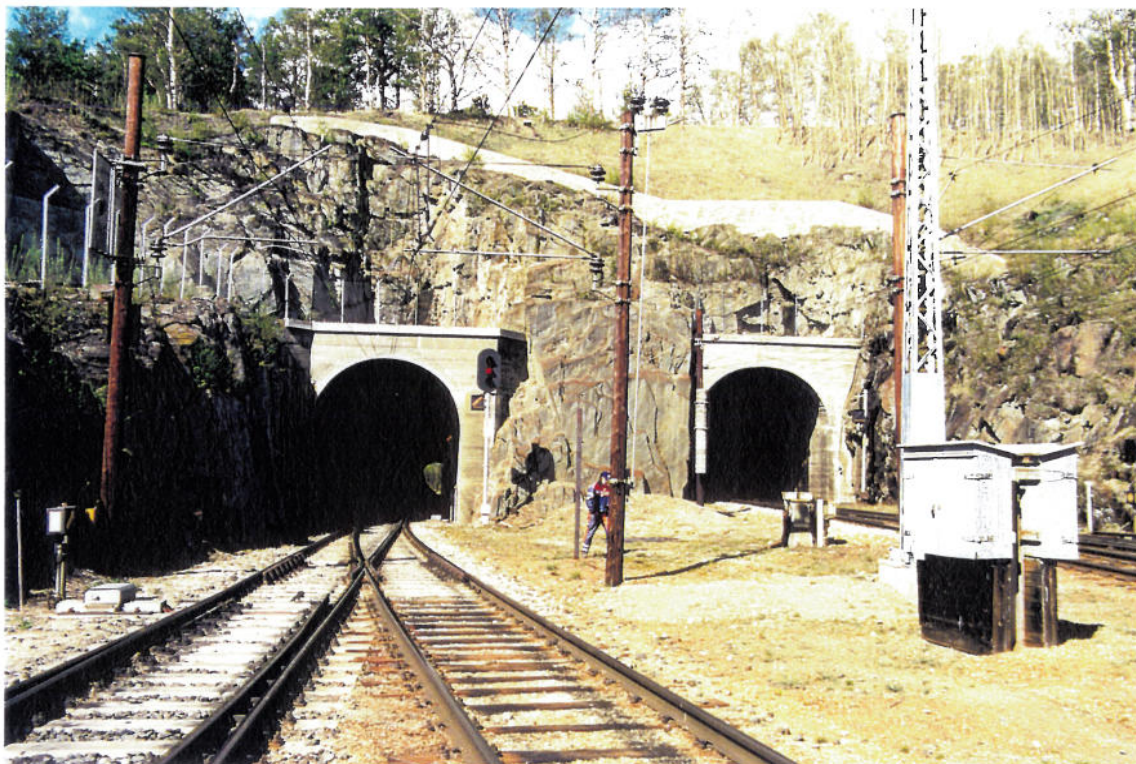
Bilde 4.8.1. Søndre påhugg til Dovrebantunnelen (km. 343.270)
