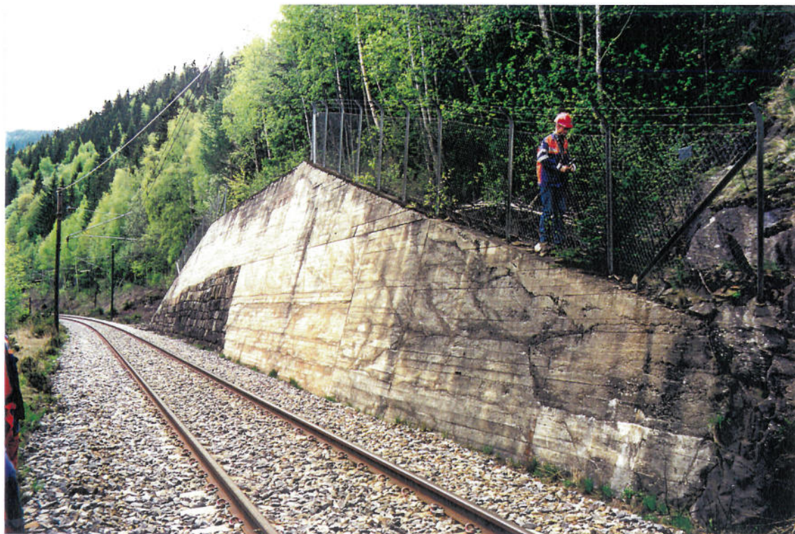
Bilde 4.1.2. Søndre skjæring, støttemur til Søndre Rankleiv tunnel (km. 240.260).
