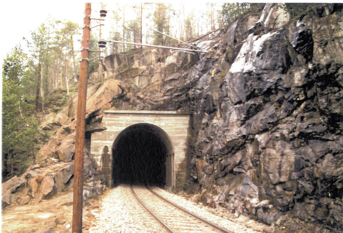
Bilde 4.9.1. Søndre påhugg til Grønbogen vendetunnel (km. 350.066)
