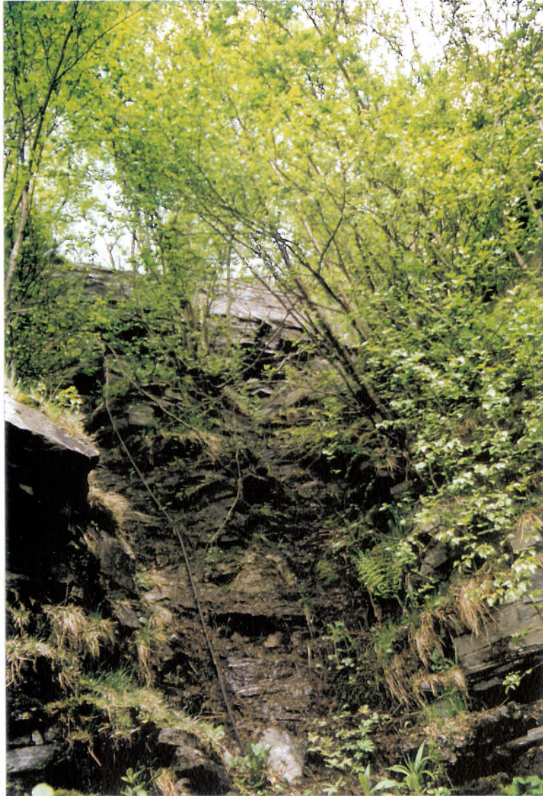
Bilde 5.5.1.3. Skjæring til Kylling tunnel.
