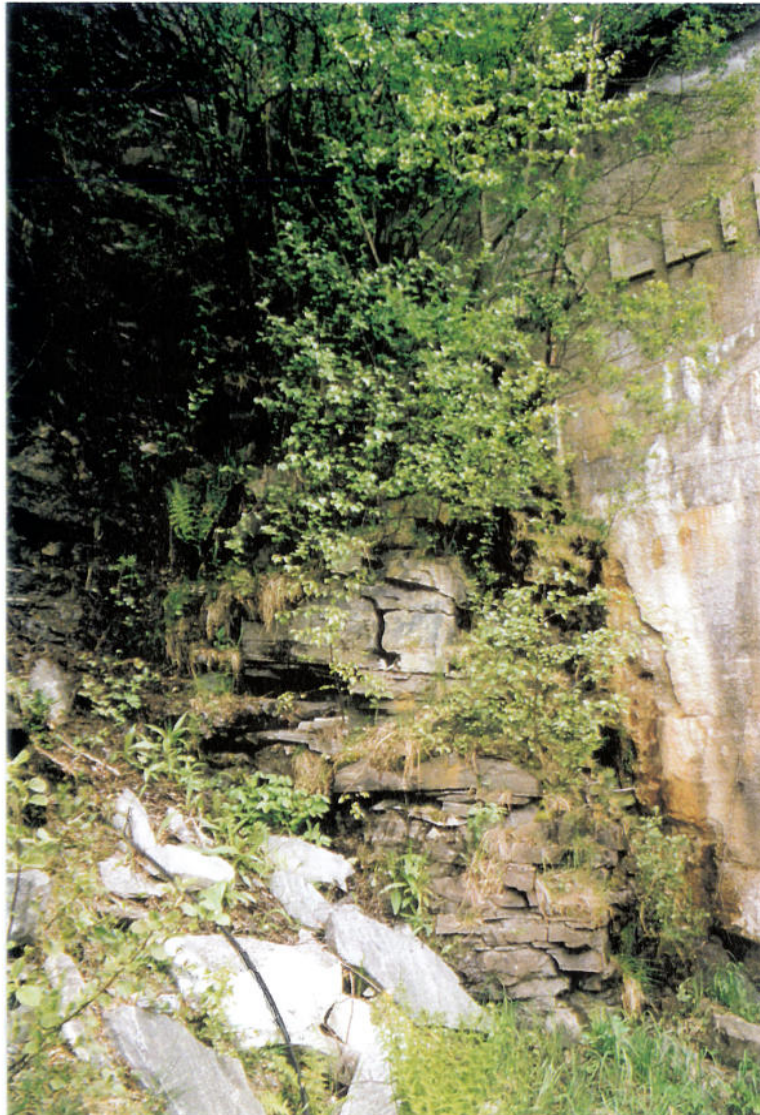
Bilde 5.5.1.4. Skjæring til Kylling tunnel.
