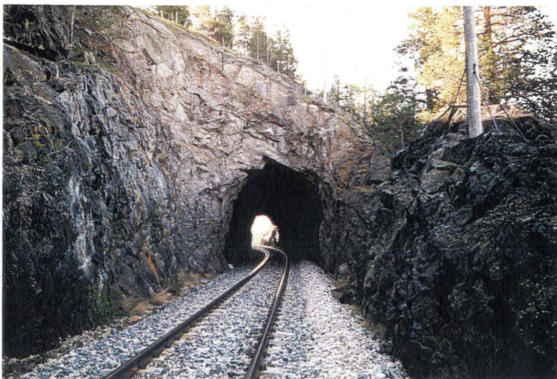
Bilde 5.2.2. Nordre påhugg til Bottemstunnelen (km. 350.858).
