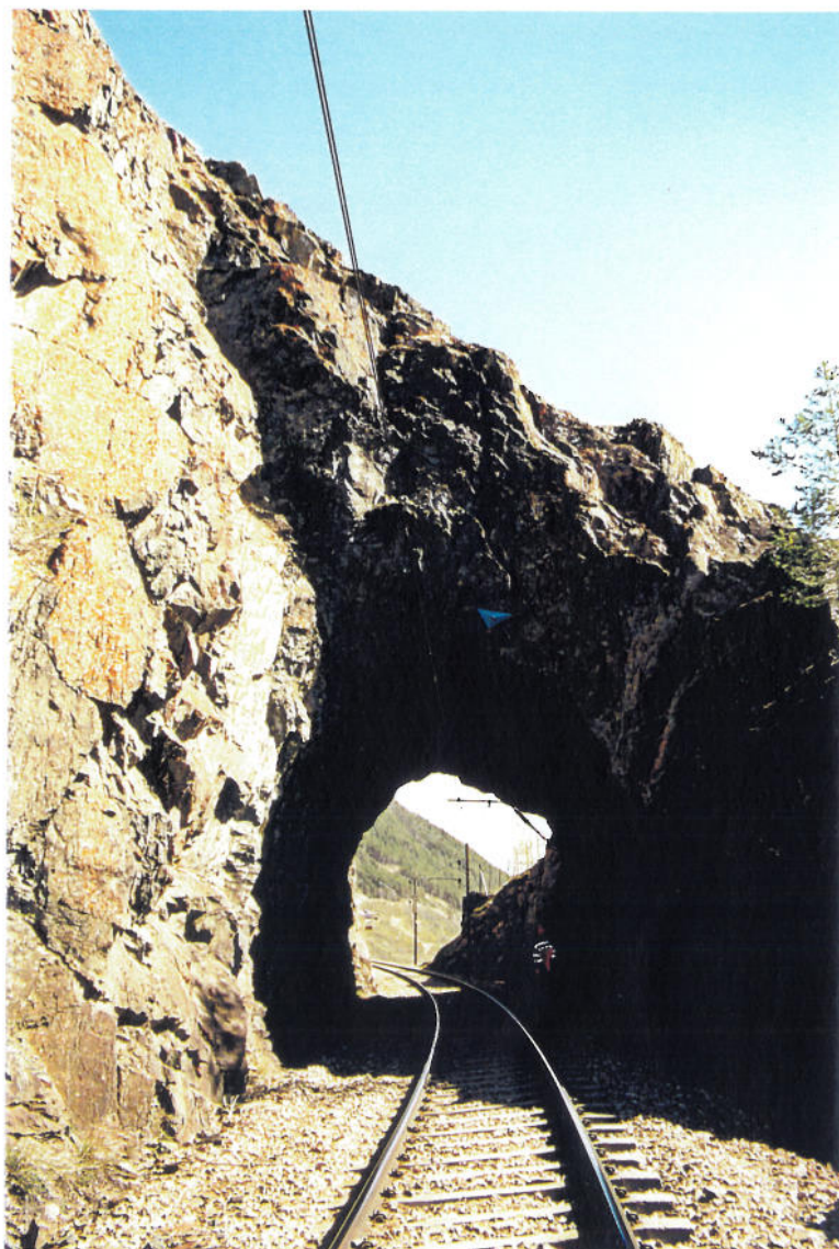
Bilde 4.6.2. Nordre påhugg til Schjelle tunnel (km. 341.026).
