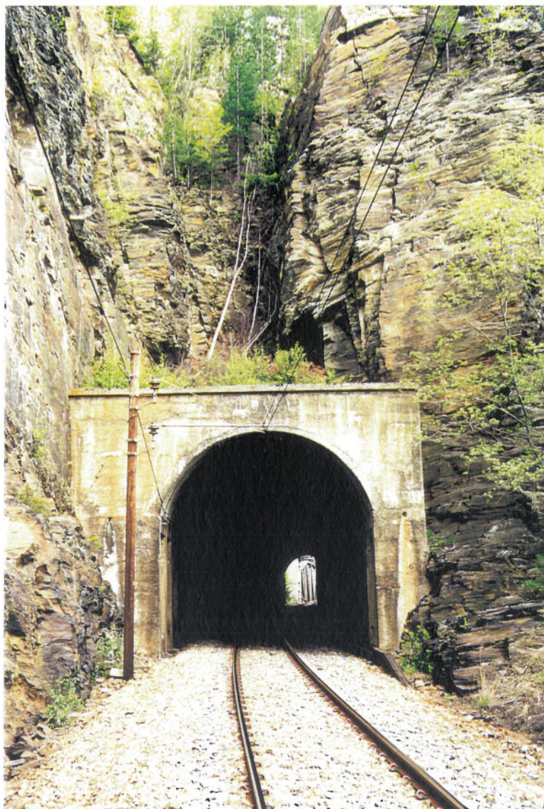
Bilde 4.2.2. Søndre påhugg til Nordre Rankleiv tunnel (km. 240.780).
