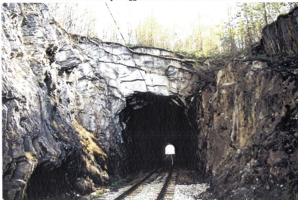
Bilde 4.8.2. Nordre påhugg til Dovrebantunnelen (km. 343.406).
