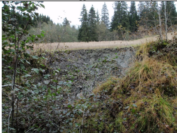
Bilde Le 9 Utglidning i jordekant ved jordbruksdrens (ikke bekkeerosjon)
