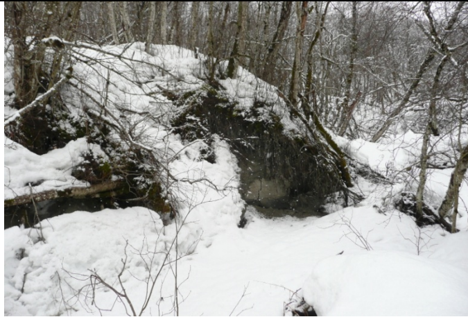
Bilde S 0 3-4 m høy overflateutglidning i Stokkaunetsona
