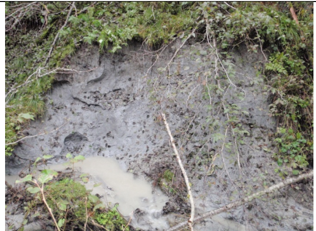
Bilde Le 6 Erosjon i yttersving østside, 2 m vertikal leirvegg
