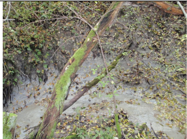
Bilde L 8 Sidebekk-Skånøy: Erosjon i leire i ytersving, ca 2 m høyt
