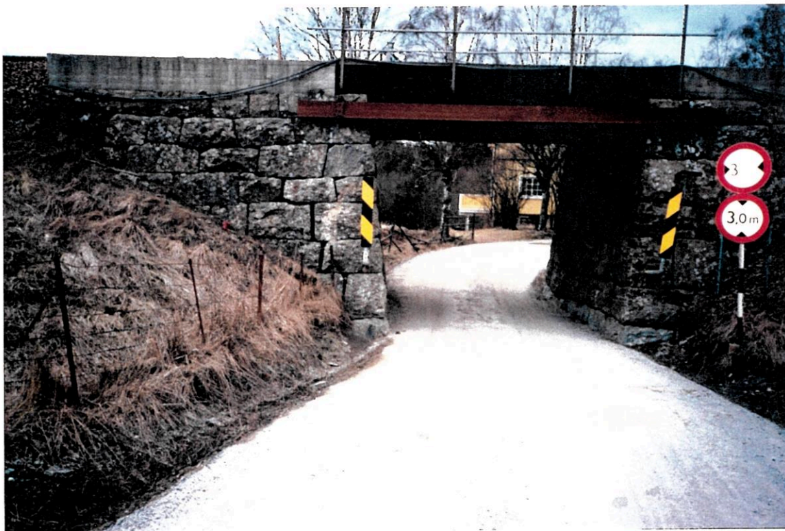
Bilde nr. 2 Undergang ved Kaaen fra øst
