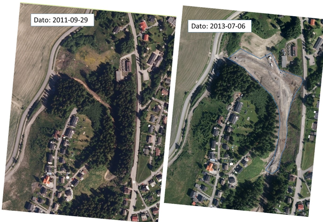
Figur 2 Oppfylling i ravine vest for Bråteveien. Venstre: Bilde fra 2011, oppfylling ikke påbegynt. Høyre: bilde tatt i juli 2013; oppfyllingsarbeider i gang. Bilder fra www.senorge.no .
