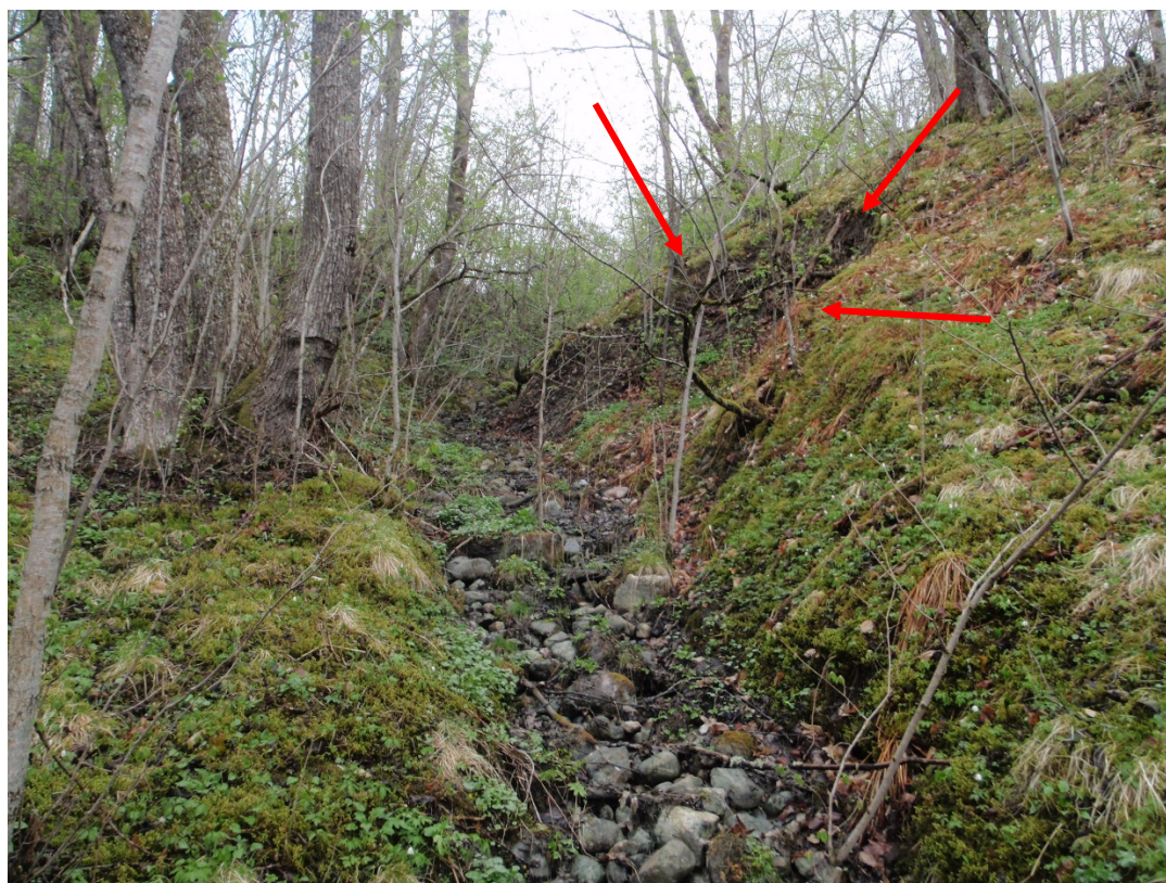
Figur 5: Bilde nr. 236 viser overflate glidning pga. i en mindre ravine (se Tegning F1 for lokalitet)
