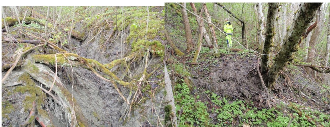
Figur 3 Bilde nr. 229 (vesntre) og bilde nr. 230 (høyre) viser noe erosjon og overflate glidninger i skråningen oppstrøms for Nedre Leirfoss.
